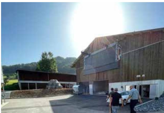
Fig. 1: Ampliamento del deposito di mangimi con un locale per l'impianto di cogenerazione
