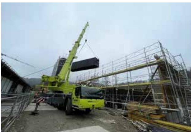
Einbringung Biogasanlage
