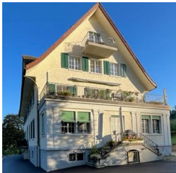
MFH «Götschihof», Reppischtalstrasse 1
